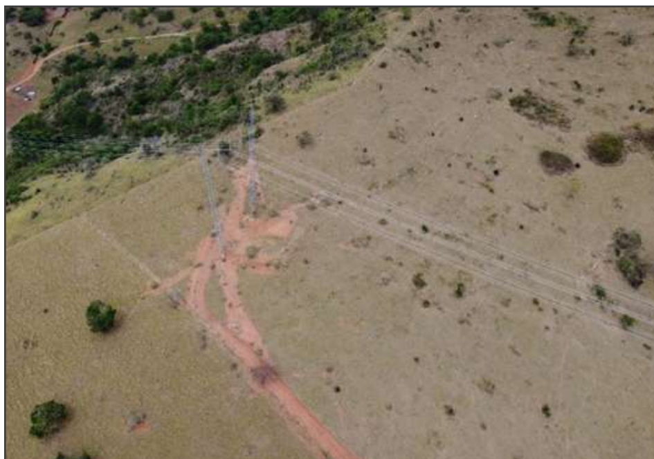
Foto 02: Construção de acessos às torres para construção e manutenção das linhas de transmissão. (Fonte: Autor)
