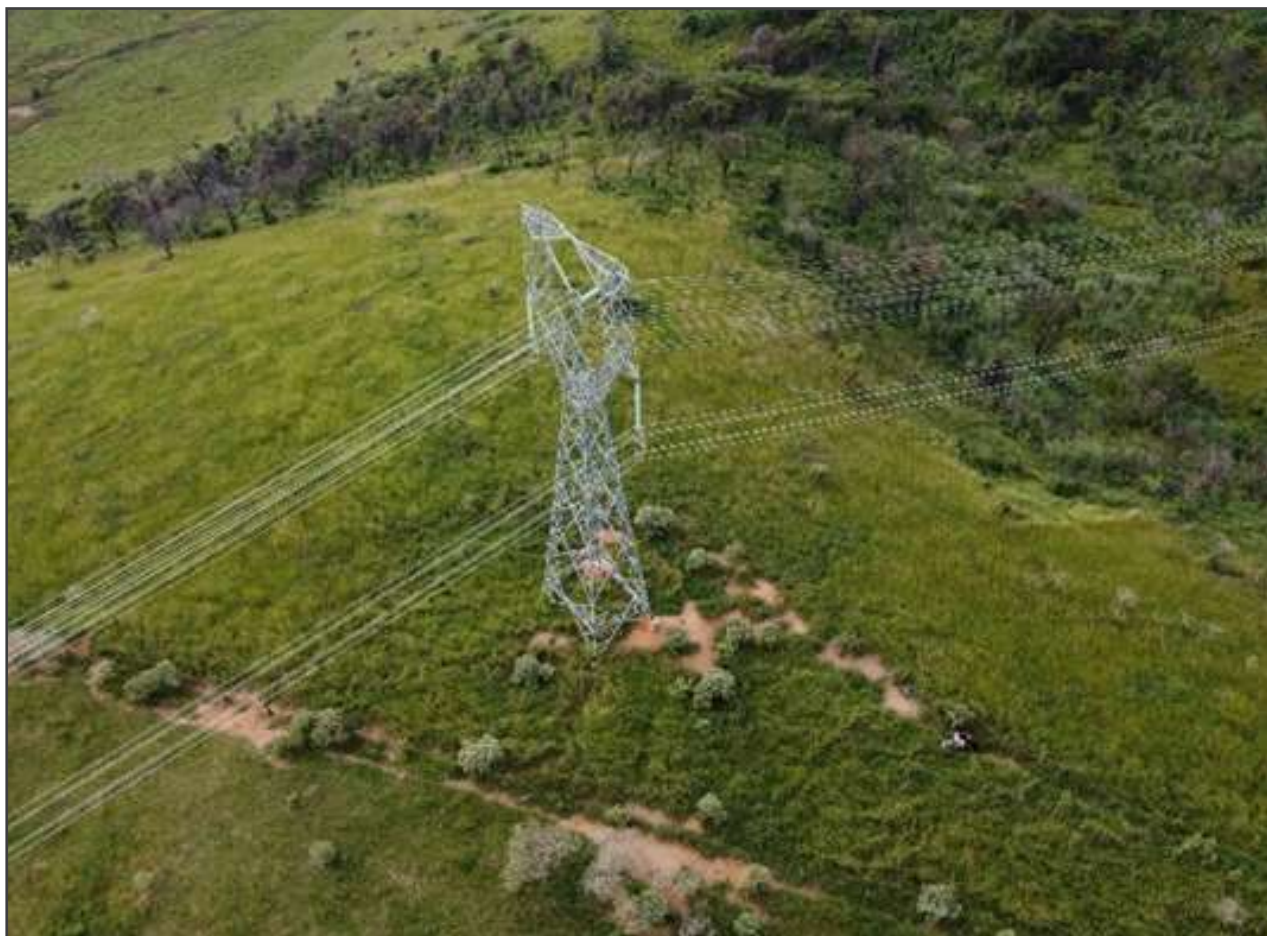
Foto 01: Instalação da linha de transmissão sobre área de pastagem. Nota-se que os bovinos conseguem realizar o pastejo sob as áreas da faixa de servidão. (Fonte: Autor)
